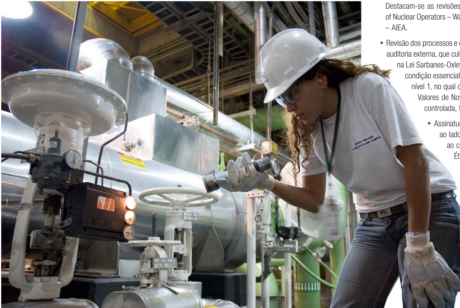
Técnica inspeciona válvula no edifício da turbina
